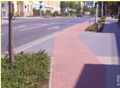
Heranführen des Radweges an die Fahrbahn
